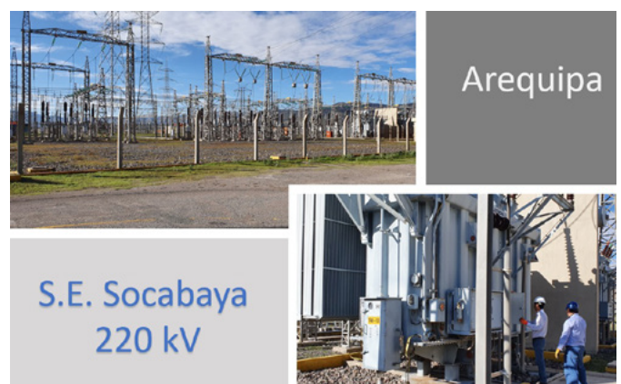
Figura 14. Instalación de LISA en SE Socabaya. Fuente propia.
