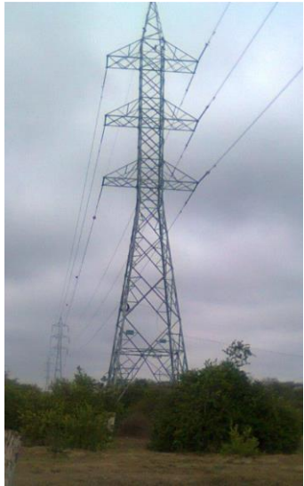
Imagen: Torre frontera en lado ecuatoriano, línea de 230 kV existente
