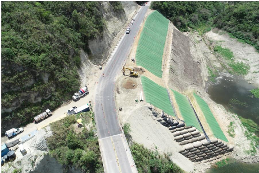
**Imagen 3.** Proceso de recuperación del talud con bolsas de geotextil gigantes. Se tiene la recuperación de toda la banca de la vía.
